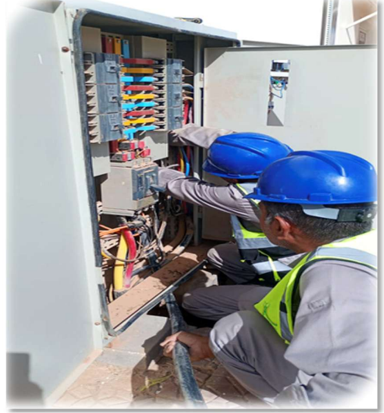
صيانة اللوحات الكهربائية
